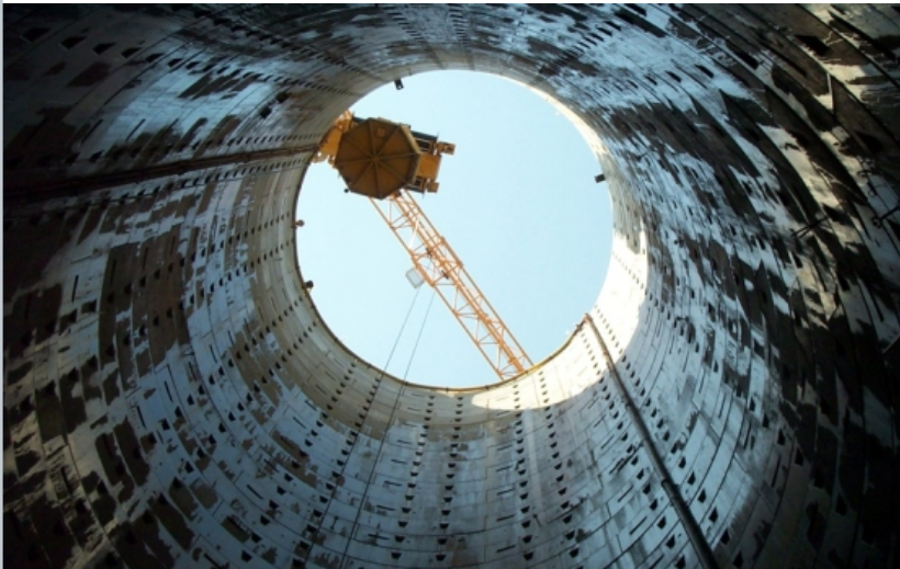
Schacht zum Erkundungsstollen Paierdorf
